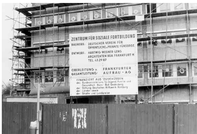
Abb. 4: Das Hans-Muthesisus-Haus im Bau
